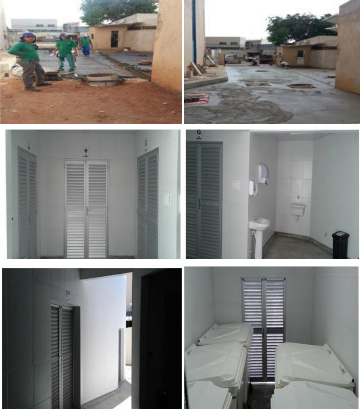
Figura 16 - Reforma do abrigo externo de resíduos
